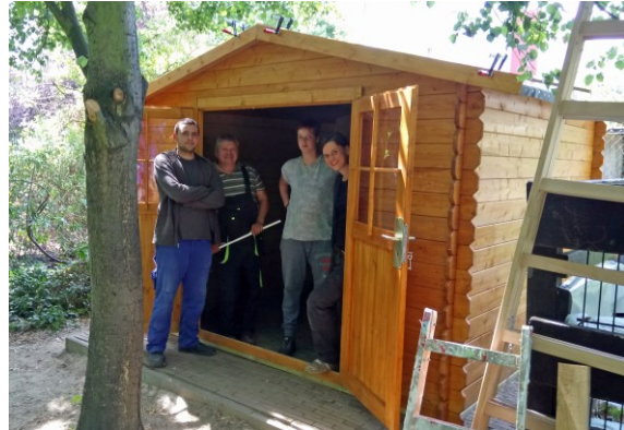
Aufbau eines Gerätehauses für das Imkerprojekt
