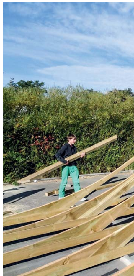
▲ Neubau der Rampe im Libertypark 2012
